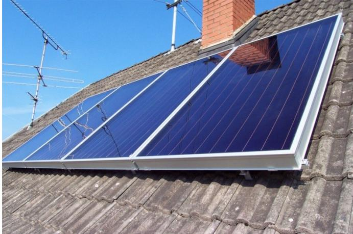
Die z.B. auf Hausdächern montierten **Solarmodule** bestehen aus einzelnen Solarzellen (s. Abb. 3.1). Diese haben eine metallisch-blaue Farbe und typischerweise eine Fläche von etwa 100 cm<sup>2</sup>. Die dünnen silbrigen Linien auf der Oberfläche einer Zelle stellen das **Kontaktgitter** dar (s. Abb. 3.2). Die Oberfläche ist mit einer
